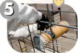
クリッパーの上に鉄筋を載せた場合
